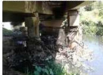
Pilares da construção da ponte da Nova Dutra dentro do rio Queimados, motivo da retenção das águas da chuvas, em época de intensa precipitação, causando um grande impacto de inundação, nos bairros vizinhos.
